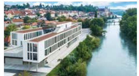
Im neuen FH III Gebäude am Campus Steyr ist die Homebase des Masterstudium Supply Chain Management und des Forschungszentrums Logistikum.
